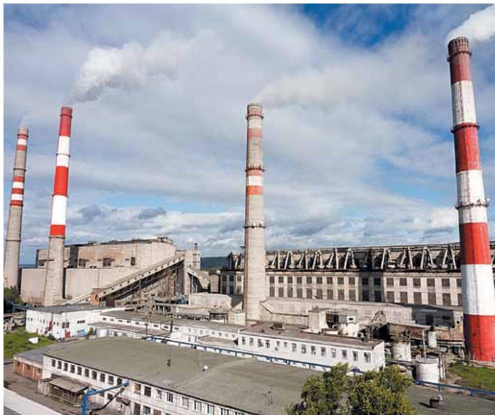
Реконструкция оборудования на Томь-Усинской ГРЭС Сибирской генерирующей компании успешно выполнена в рамках программы развития тепловой энергетики
